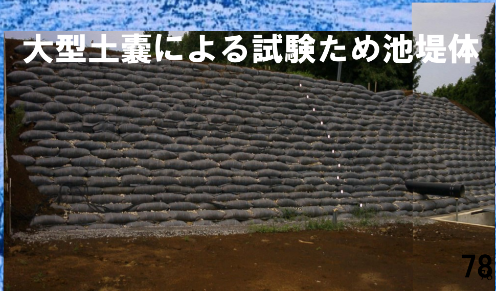
補強土工法で改修した平田池
